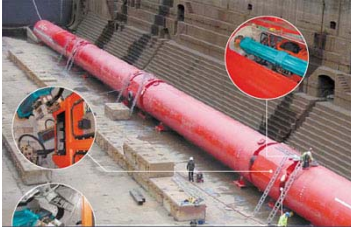
Сборка конвертера волновой энергии Pelamis
