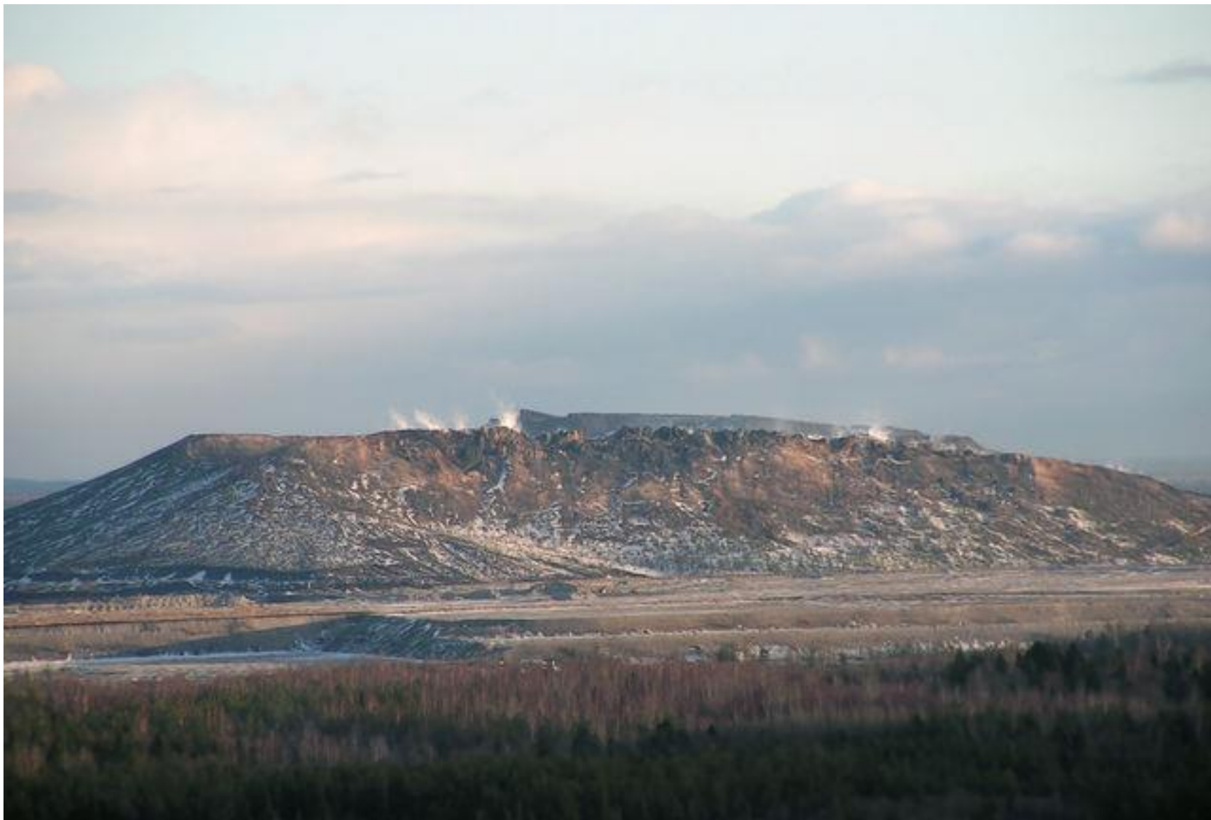
Террикон (отвал пустой породы из шахты)
