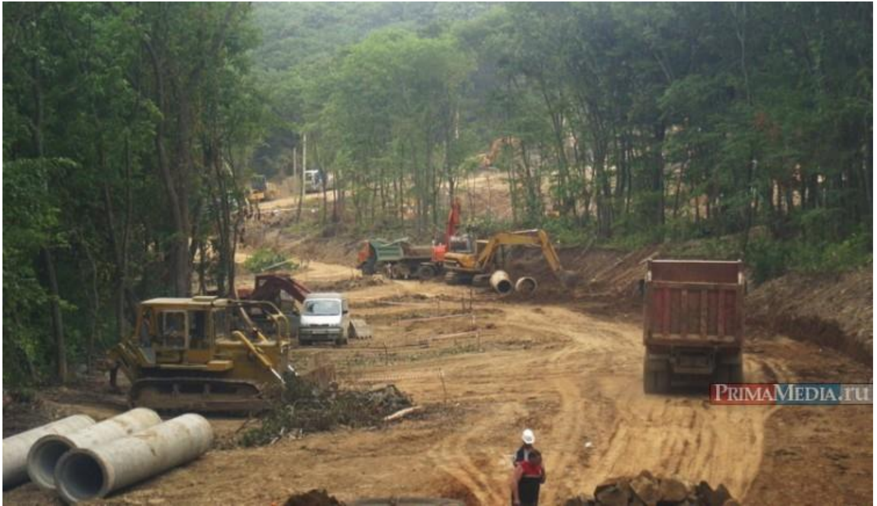
Прокладка технологических дорог
