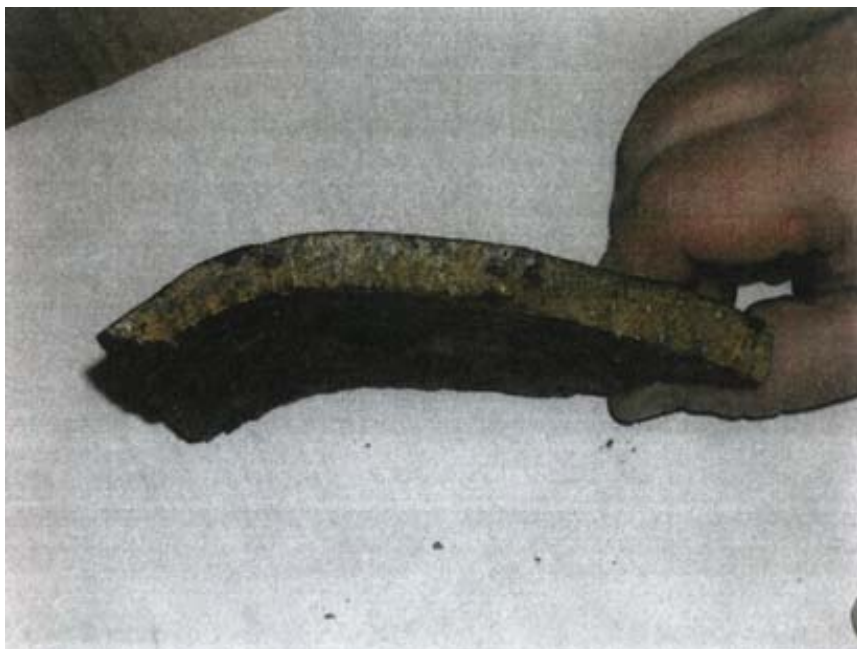
Рис. 1.15. Кусок разрушенного корпуса обратного клапана
