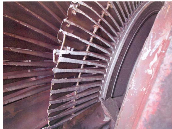
Рис. 1.33. Повреждения лопаточного аппарата
