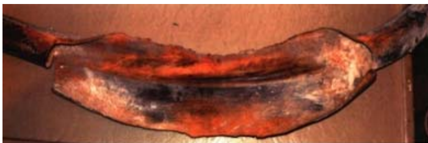
Рис.1.5. Общий вид продольного разрыва поврежденной трубы
