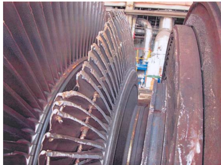
Рис. 1.32. Повреждения лопаточного аппарата
