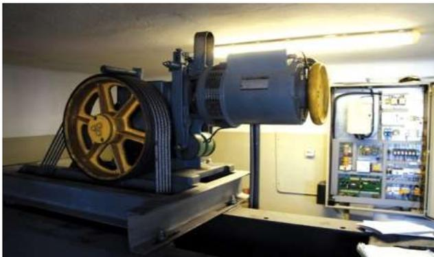
Станция управления лифтом управляет механизмами и контролирует работу лифта (безопасность). Ограничитель скорости при превышении скорости движения подаёт сигнал станции управления и лифт останавливается, если не срабатывает электронная защита, срабатывает механизм заклинивания кабины на "ловителях«(установлены сверху кабины) - кабина повисает на "направляющих".
