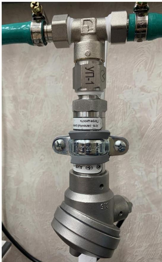
Рисунок 5.1 - Внешний вид установки датчика давления АИР-10Н
