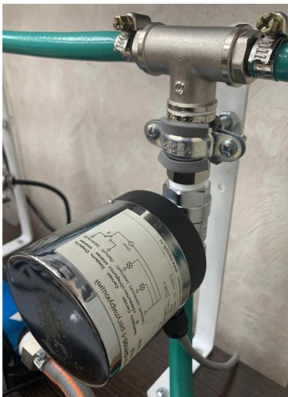
Рисунок 5.2 - Внешний вид установки шарового крана GH100-1 с приводом GH100-8Nm
