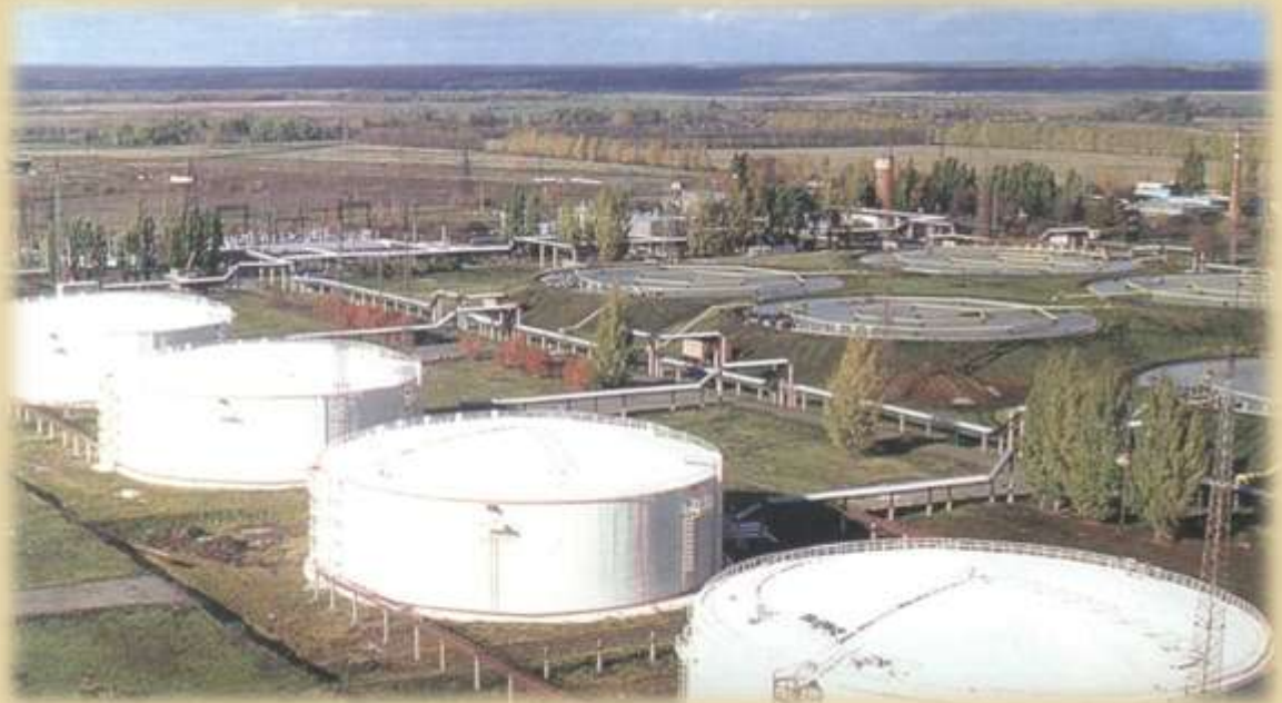
Резервуарный парк магистрального нефтепровода
