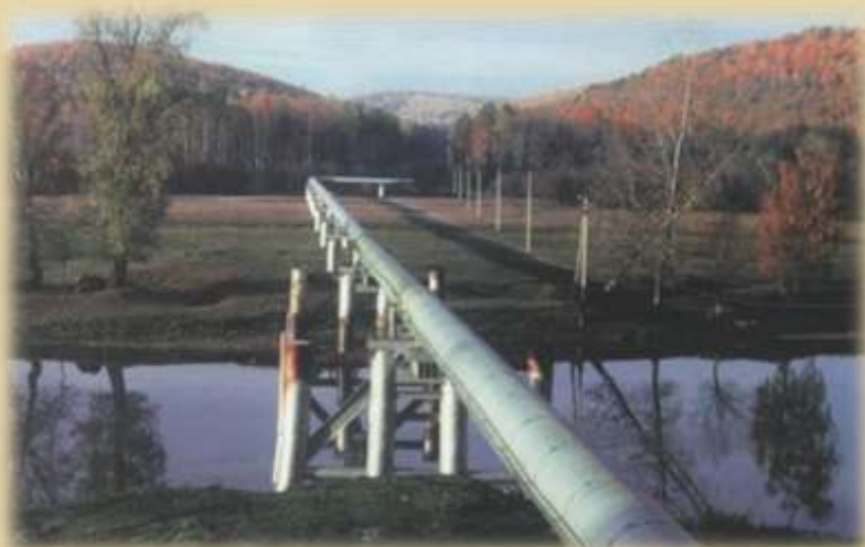
Надземный участок магистрального трубопровода
