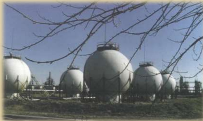
Хранилище сжиженных газов
