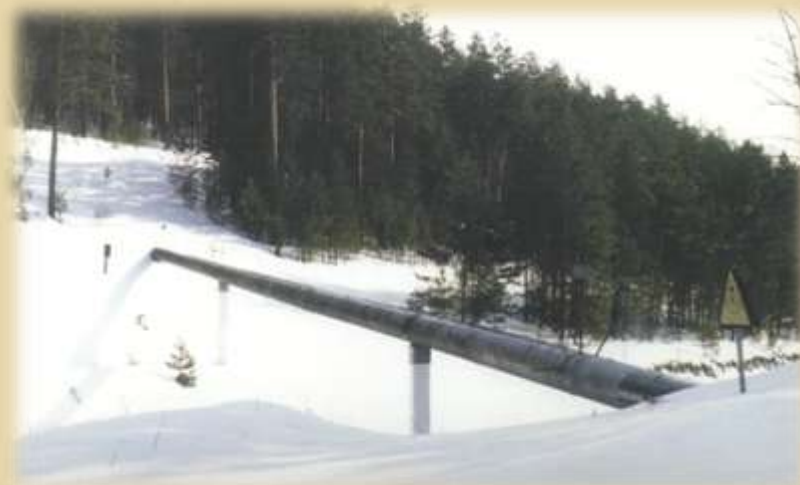
Балочный переход трубопровода
