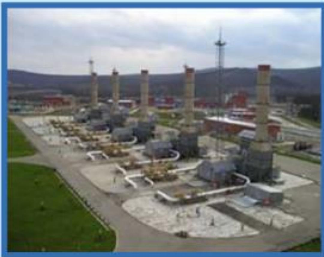
Газоперекачивающий агрегат мощностью 12 МВт на компрессорной станции «Краснодарская»
