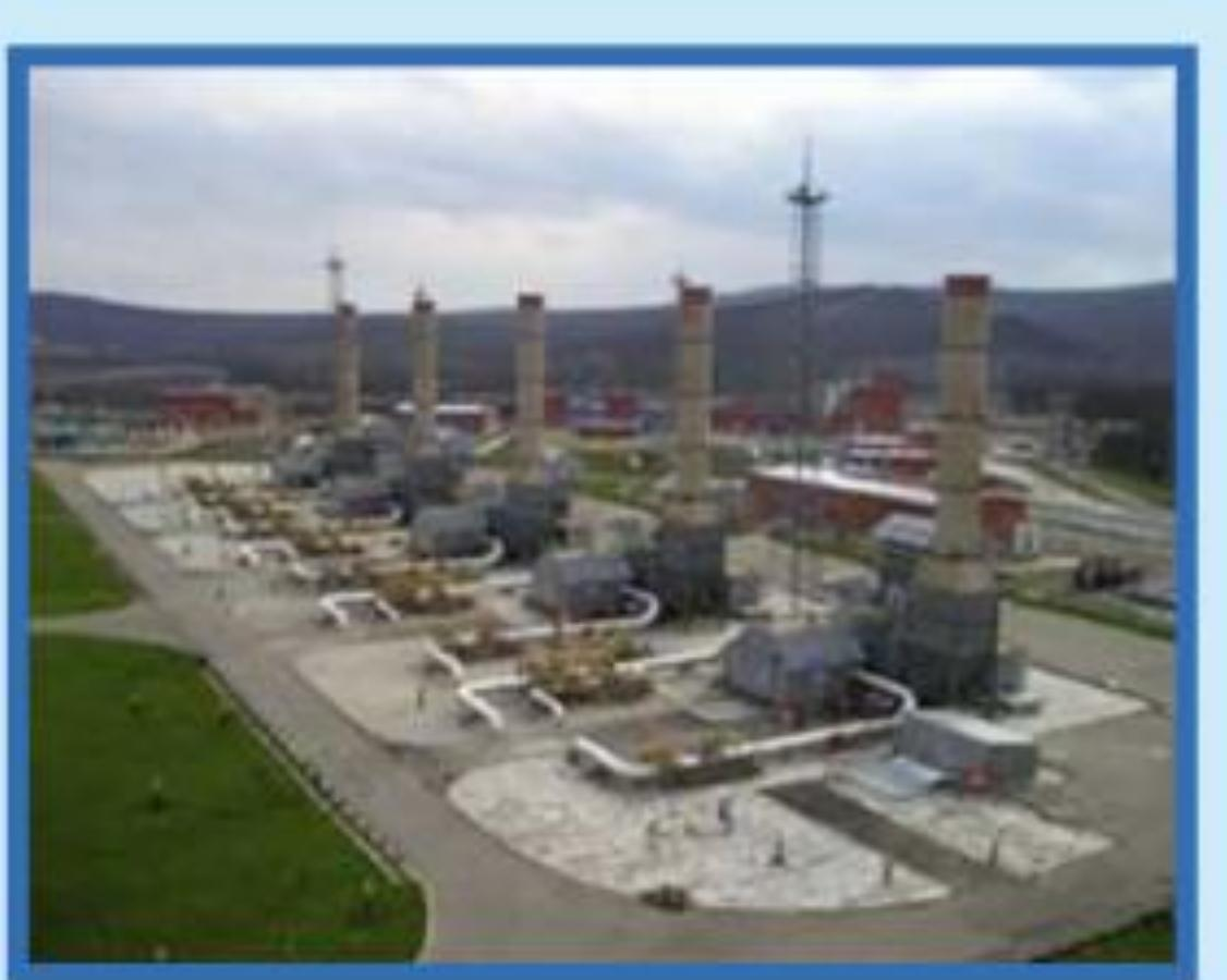
Газоперекачивающий агрегат мощность 12 МВт на компрессорной станции «Краснодарская»
