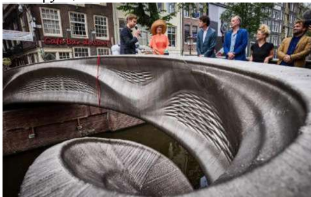
Рис.1. Мост, сваренный роботами в Нидерландах [1]
