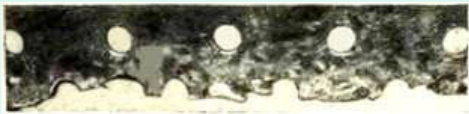
Разрыв обечайки котельного барабана по заклепочному шву, разрушенному в результате щелочной хрупкости
