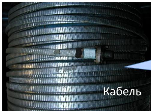
Электроэнергия на двигатель подается через специальный бронированный кабель.
