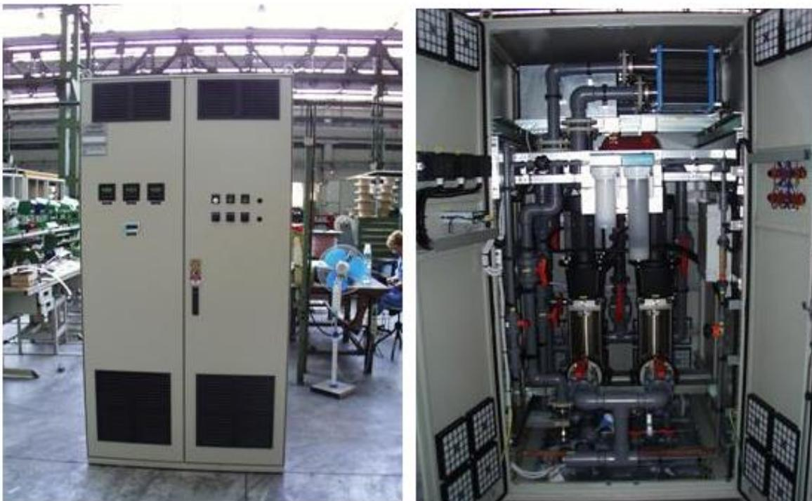
*Рис. 2.28. Система охлаждения тиристорного вентилья*
