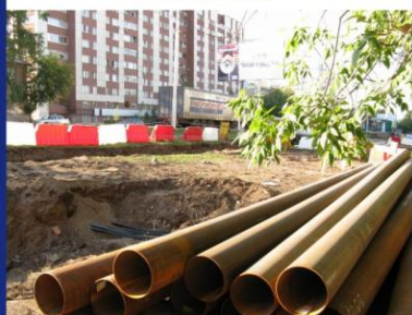
Локальный ремонт теплосетей
