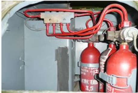
Баллоны и секция обратных клапанов УАППО «Роса»
