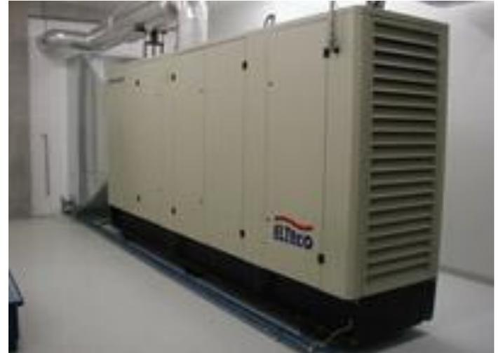
**Газовый генератор** (электростанция) — это источник бесперебойного питания, работа которого обеспечивается природным газом. По сравнению с моделями, требующими другого топлива, такой прибор более экономичен, а также характеризуется рядом дополнительных преимуществ.
