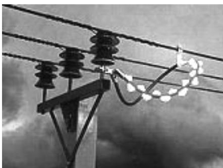
Рис. 4.5. Момент срабатывания разрядника РДИП-10
