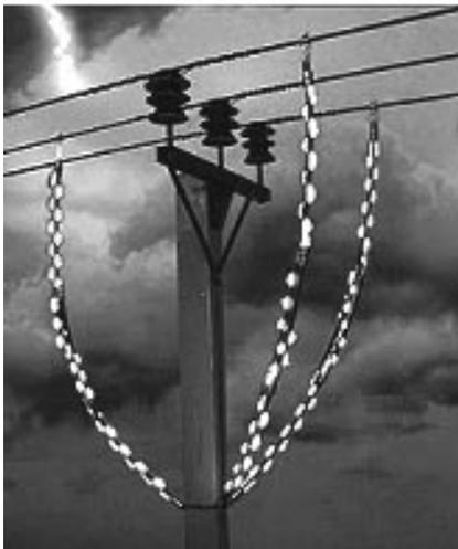
*Рис. 4.7. Момент срабатывания усовершенствованного разрядника РДИМ*
