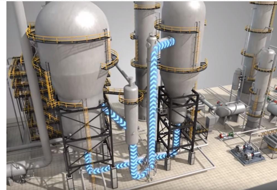
Реакторно-регенераторный блок установки каталитического крекинга
