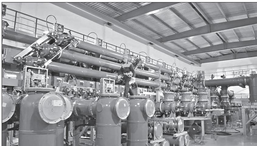
**Рис. 6.55.** Подстанция напряжением 110 кВ с элементами КРУЭ
