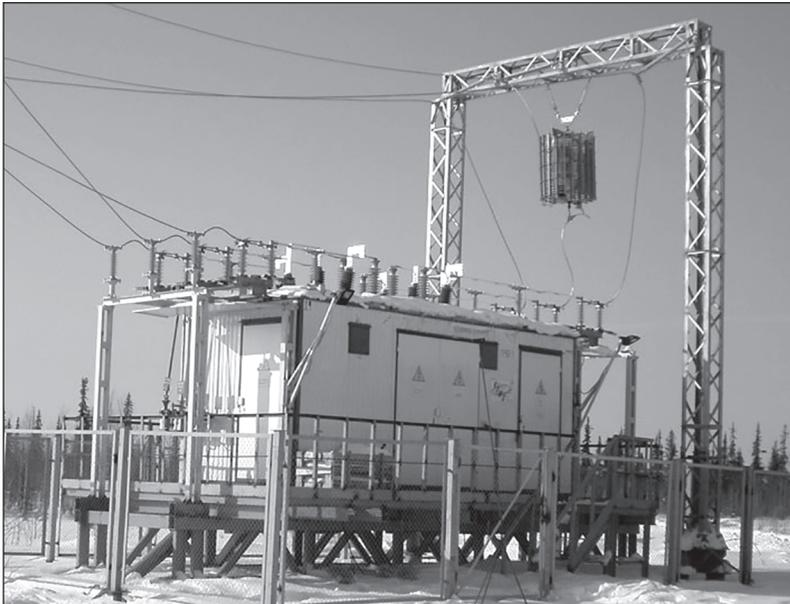
Рис. 6.57. Реклоузер на напряжение 35 кВ
