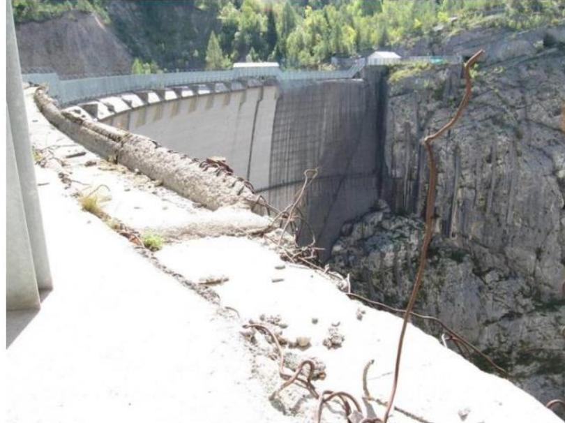
**Арочные** – криволинейные в плане плотины, представляющие собою своды с вертикальной осью, цилиндрические или же двойкой кривизны (купольные). Нагрузку от давления воды они передают через свои пяты на сложенные скальными породами берега. Их материал – бетон.
