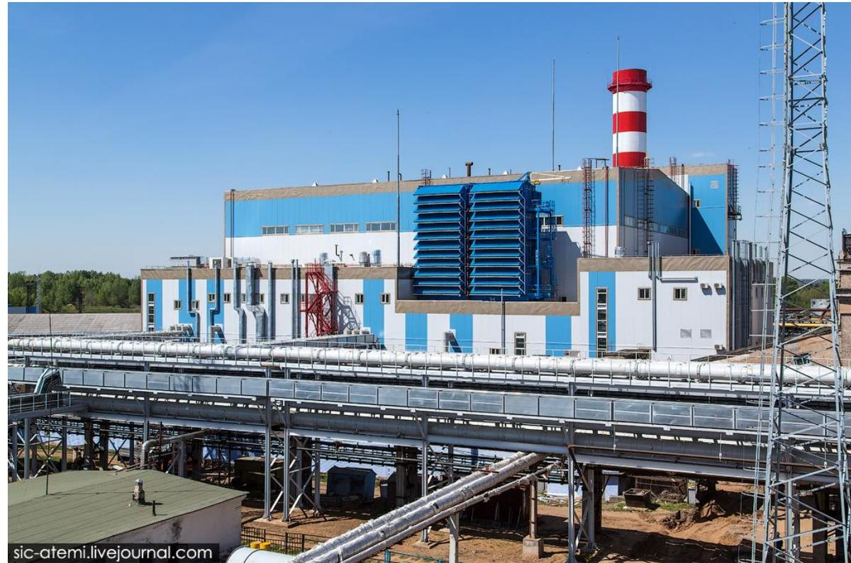
В целом мощность ПГУ может быть 200...250 МВт с приемлемыми технико-экономическими показателями, а их КПД достигает значений 50...64 %, т. е. оказывается больше, чем у газотурбинных и паротурбинных установок в отдельности. ПГУ могут создаваться на базе энергоблоков КЭС и ТЭЦ.
