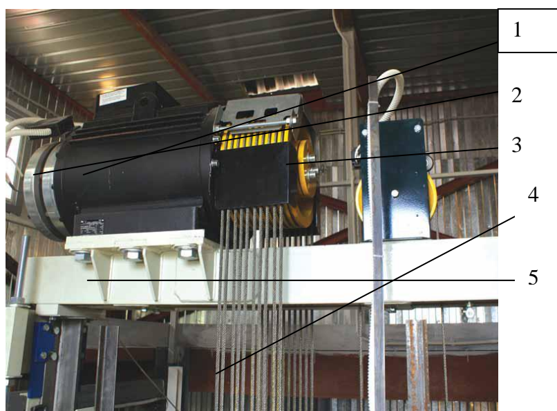
Рис. 2.41. Электропривод лифта с электродвигателем ZETATOR
