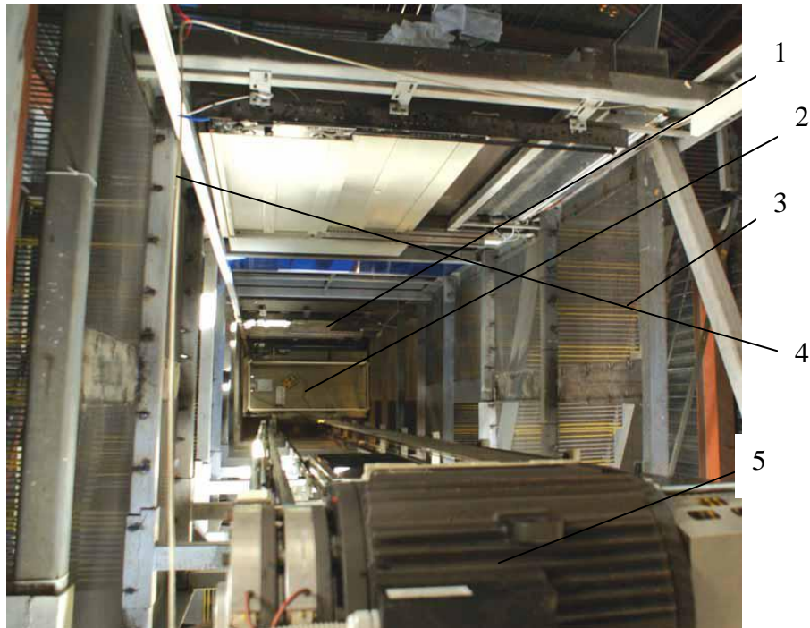
Рис. 2.39. Шахта лифта (вид сверху)
