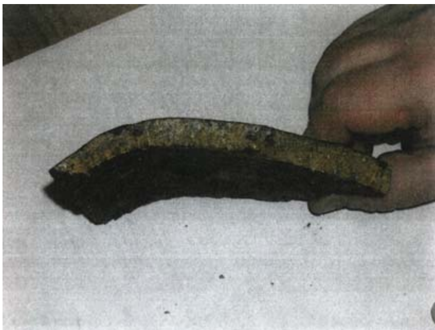
Рис. 1.15. Кусок разрушенного корпуса обратного клапана
