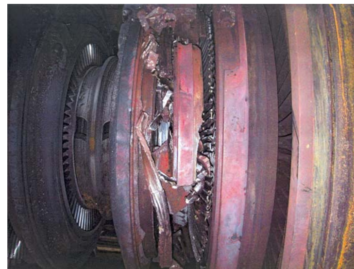
Рис. 1.29. Внешний вид поврежденной диафрагмы
