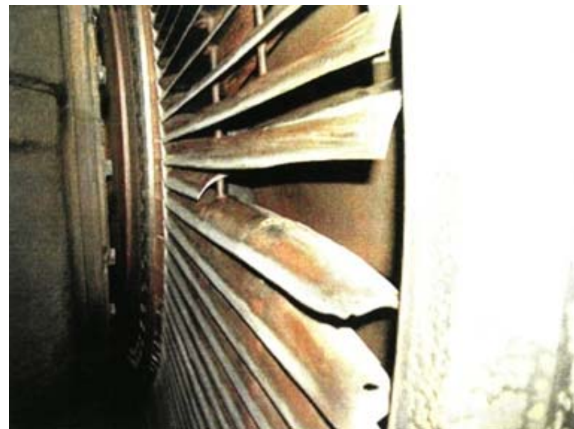
Рис. 1.16. Расположение поврежденной лопатки
