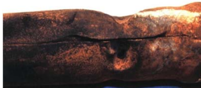
Рис.1.13. Трещина в змеевике конвективного пароперегревателя
