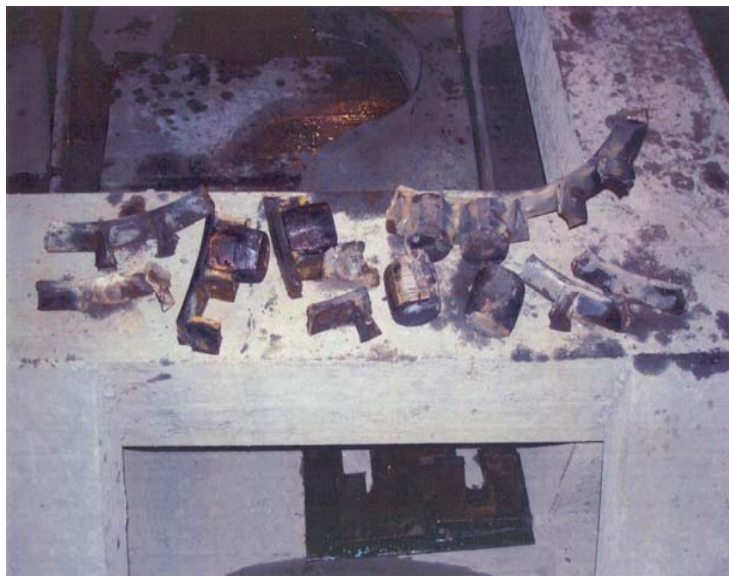
Рис.1.36. Фрагменты разрушенного подшипника
