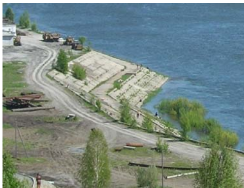
Рис. 56. Защита бетонными плитами
