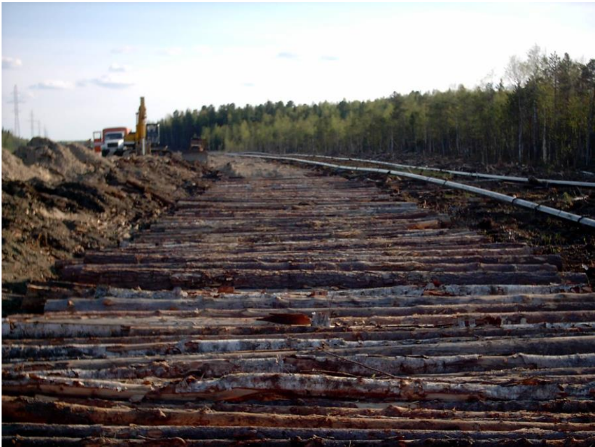
Рис. 1. 21. Временная дорога вдоль газопровода
