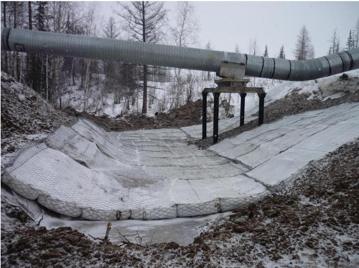
*Рис. 3.2. Укрепление склонов*
