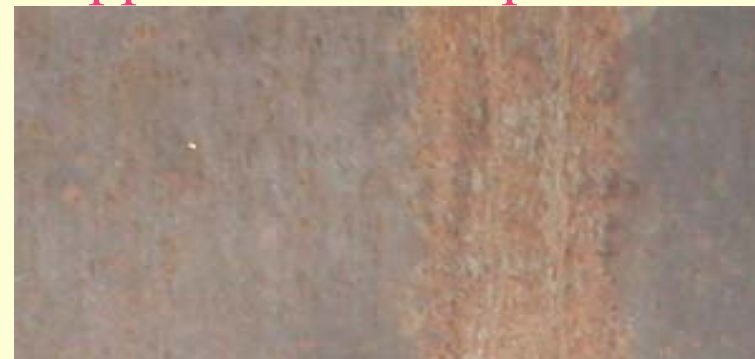
Коррозия под напряжением
