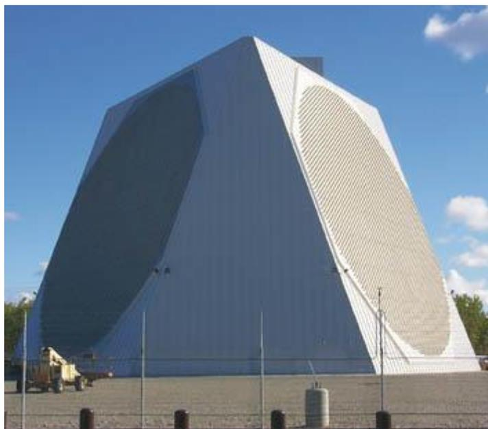
*Рис. 34. Антенна на фазированной решетке американского радара в Калифорнии. Фото: U.S. Army Corps of Engineers*
