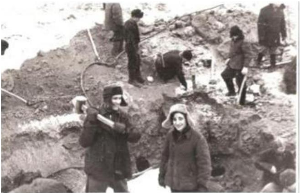
На прокладке теплотрассы. В траншее Юрия Скачков и Алла Краковская.
