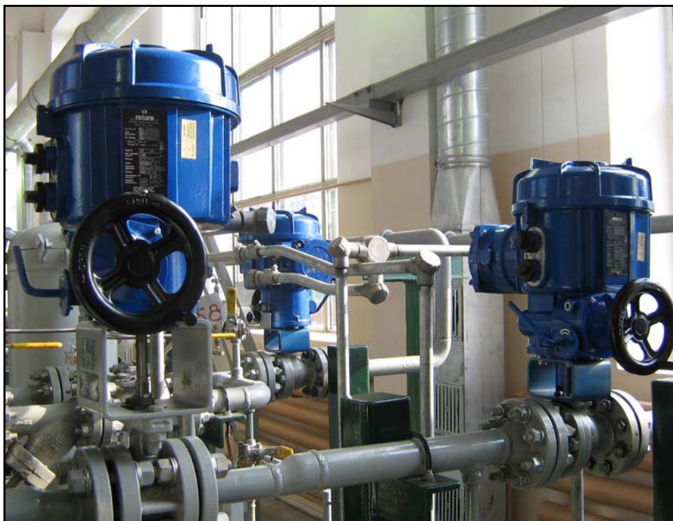
Рис. 3.39. Регулятор расхода, выходная задвижка БИК
