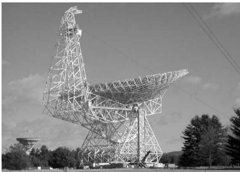
*Рис. 3.30. Самый большой полноповоротный параболический радиотелескоп вступил в строй в 2000 году в США. Телескоп весит более 7,5 тыс. т, однако он может быть направлен в любую точку на небе с точностью, превосходящей одну тысячную градуса*
