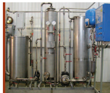
Водоочистной комплекс «Аэрозон-0,5» производительностью до 0,5 м 3 /ч
