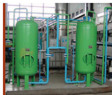
Водоочистной комплекс «Аэрозон-3,5» производительностью до 3,5 м 3 /ч
