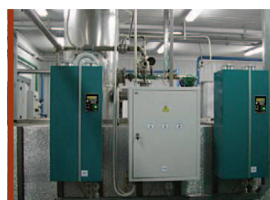
Водоочистной комплекс «Аэрозон-10» производительностью до 10 м 3 /ч
