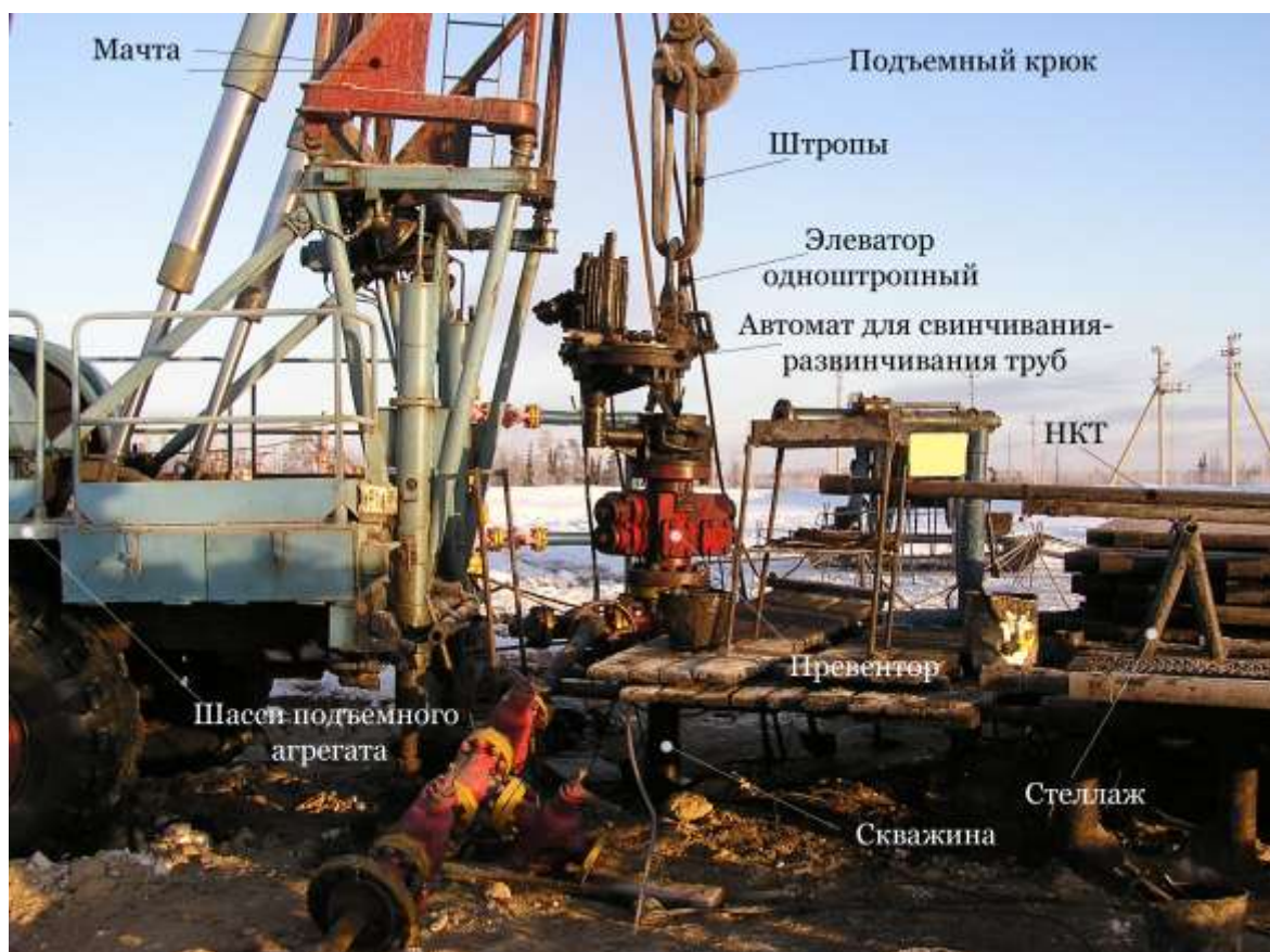
Рис. 14.2. Подъемный агрегат на устье ремонтируемой скважины
