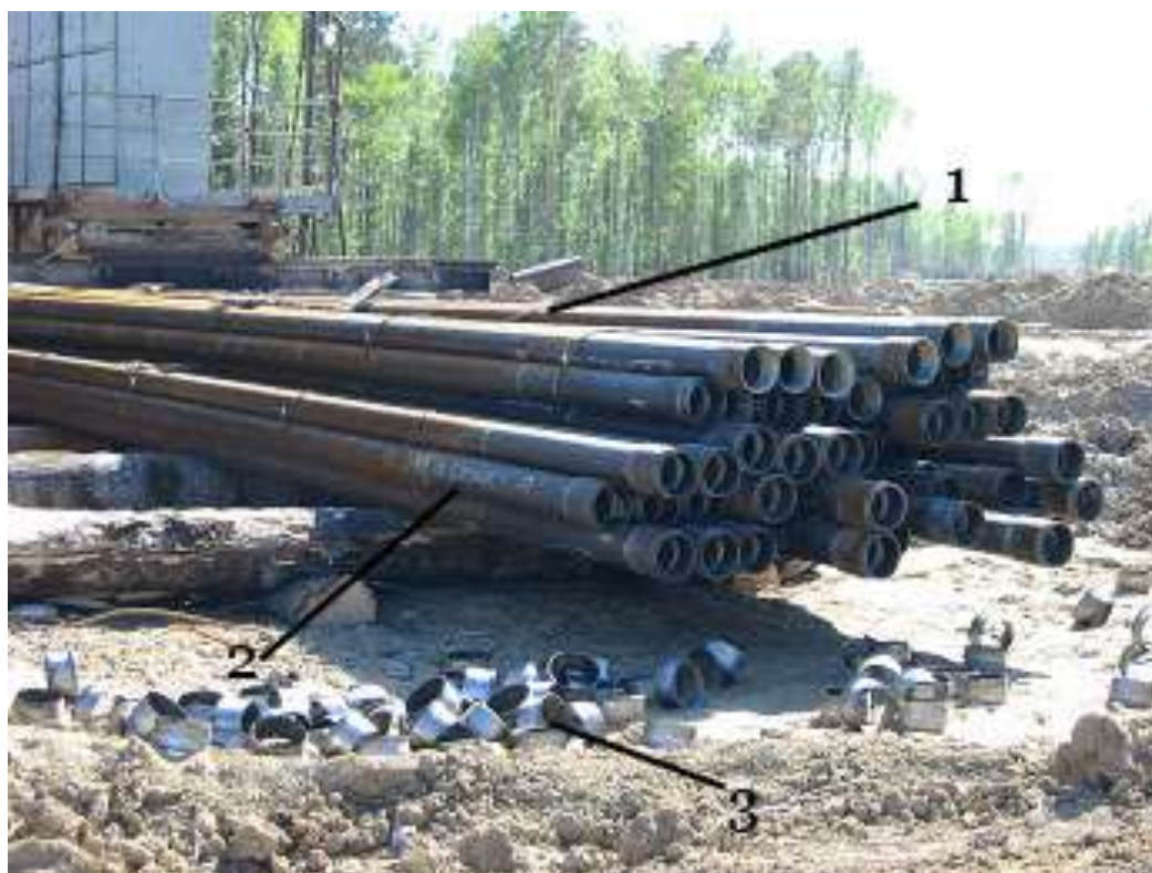
Рис. 4.6. Обсадные трубы, подготавливаемые к спуску в скважину: 1 – обсадные трубы; 2 – маркировка труб; 3 – предохранительные клапаны
