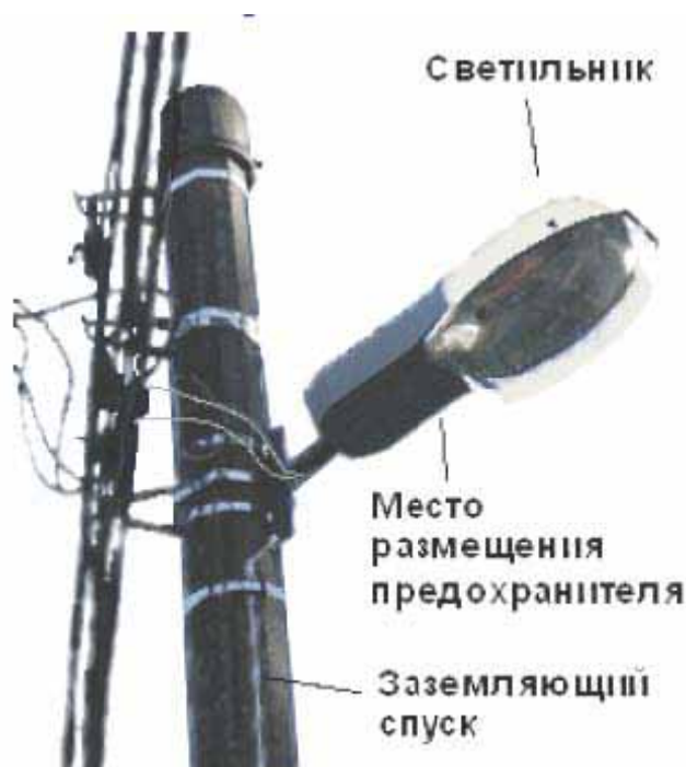
Рис. 1.30. Монтаж уличного светильника
