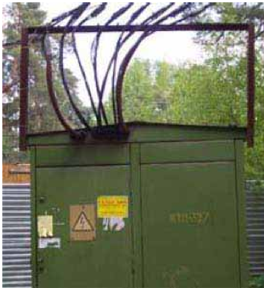
Рис. 1.35. Закрепление вводов на подстанцию
