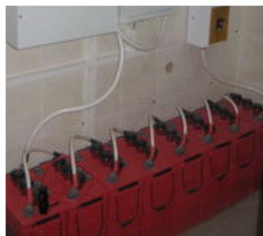
*Рис.32. Размещение аккумуляторов и монтаж электрических соединений*
