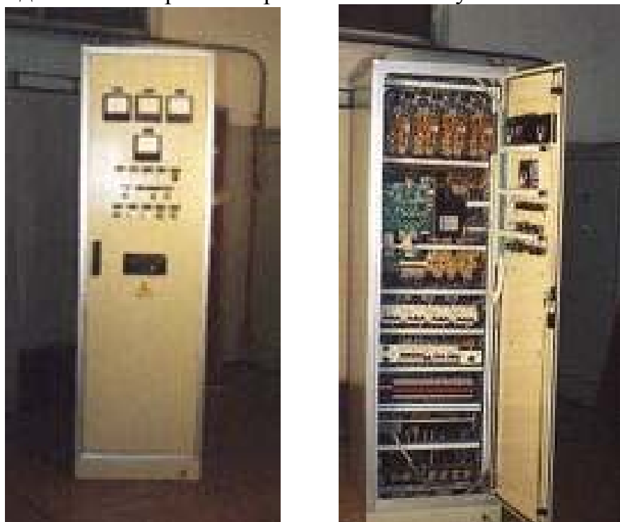
Рис. 3.22. Конструктивное выполнение систем возбуждения турбогенераторов
