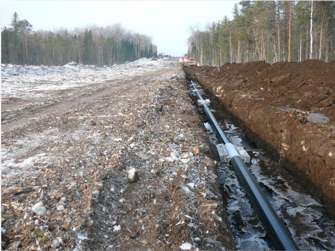
Рис. 10.33. Газопровод в траншее перед засыпкой
