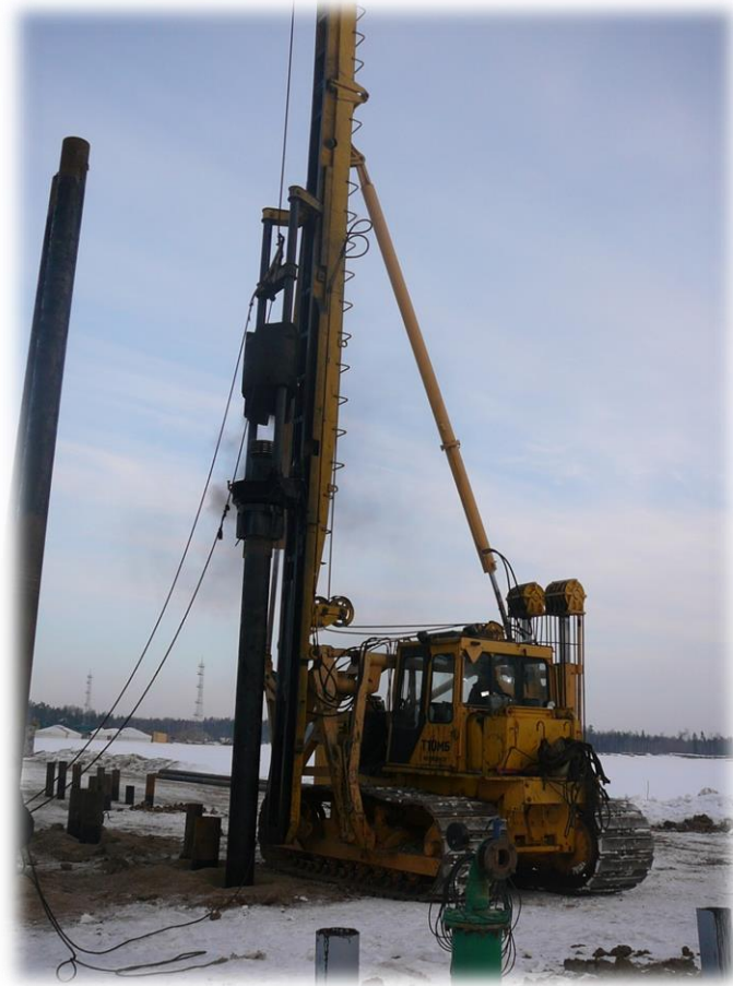
Рис. 7.45. Забивка свай дизель-молотом при сооружении ГКС
