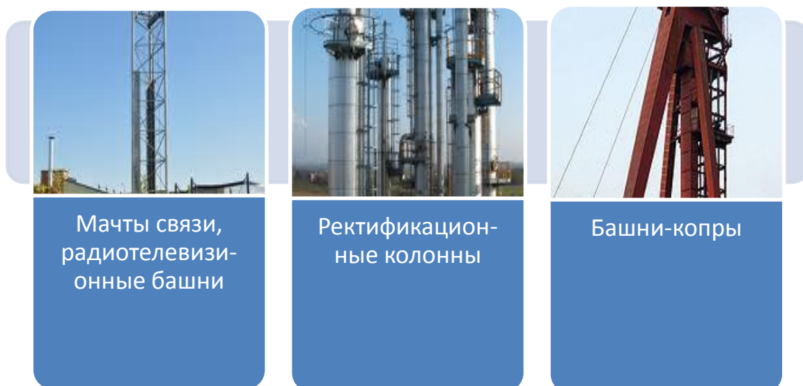
Рис. 8.22. Виды сооружений башенного типа
