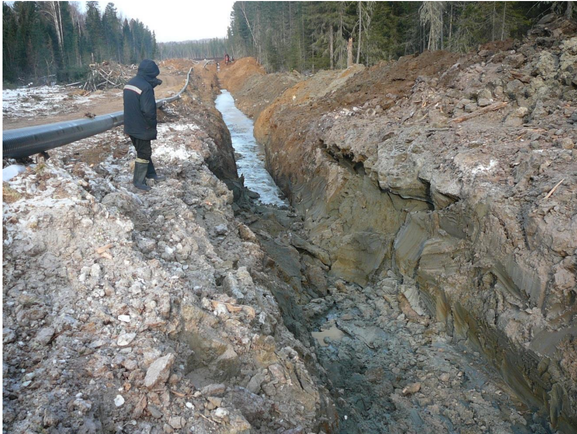
4. Геодезические работы при сооружении подземных нефтегазопроводов
