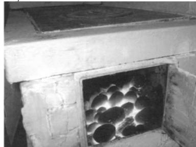
Рис. 5. Горение топливных гранул в печи каменной кладки
