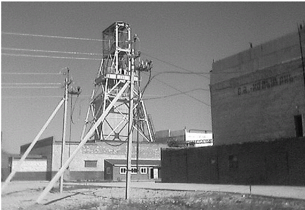
Рис. 2.1. Копер главного ствола рубцовского рудника (Алтайский край)
