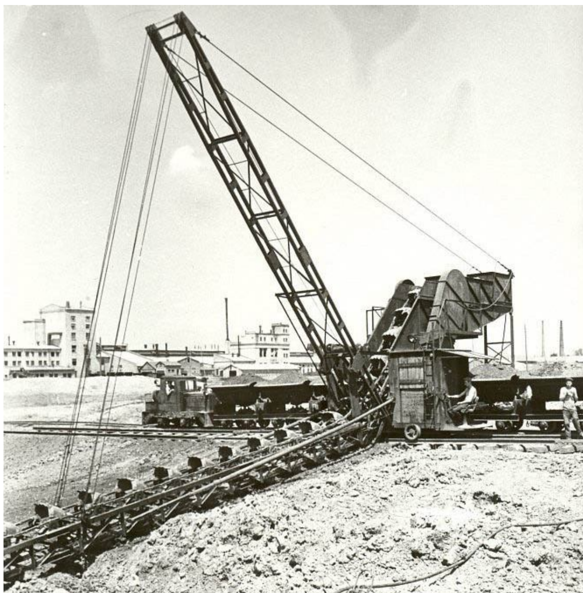
Рис. 3.15. Экскаватор цепной продольного копания EM-201
