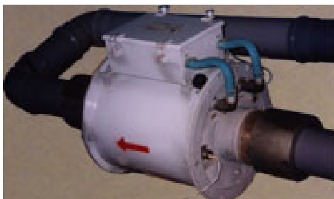
Рис. 160. Электромагнитный датчик расхода
