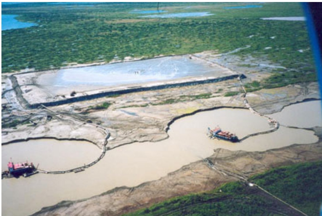
Рис. 16. Внешний вид намывного кустового основания
