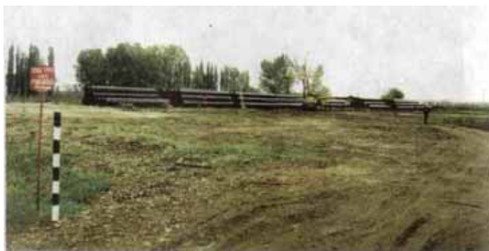
Рис. 3.1. Складирование труб на подготовительной площадке
