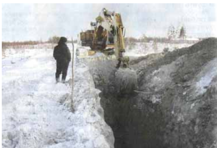
Рис. 4.3. Разработка траншеи в частично мерзлых грунтах одноковшовым экскаватором
