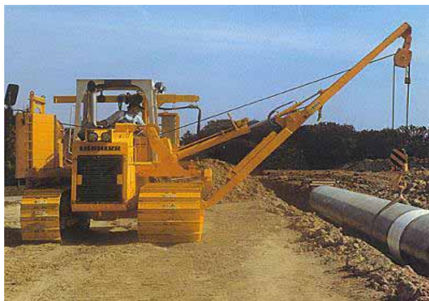
Рис. 5.9. Трубоукладчик LIEBHERR RL-22 B Litronic
