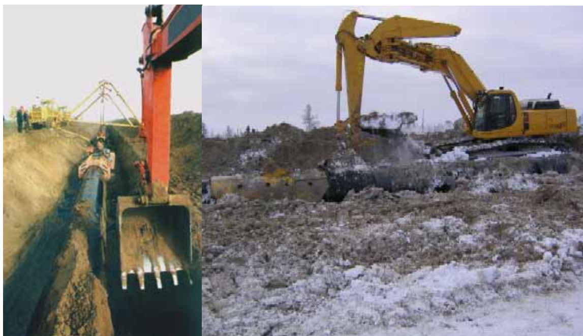
Рис. 4.19. Разработка траншеи одноковшовыми экскаваторами [5]
