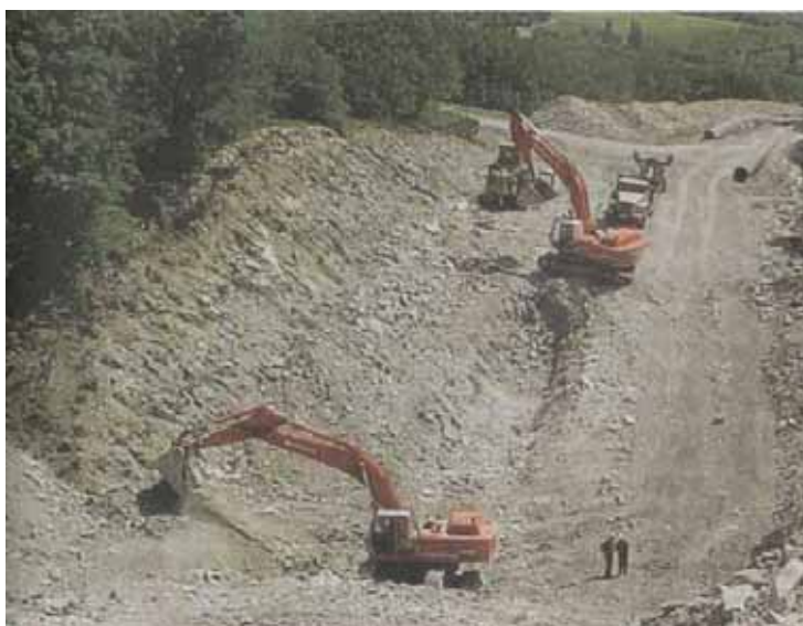
Рис. 4.1. Разработка траншеи одноковшовым экскаватором в горах [8]
