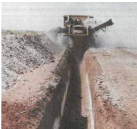
Рис. 4.2. Разработка траншеи роторным экскаватором [8]
