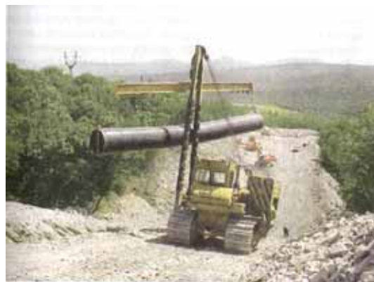
Рис. 3.3. Транспортировка труб трубоукладчиком
