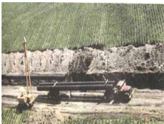
Рис. 3.2. Перевозка секций труб
