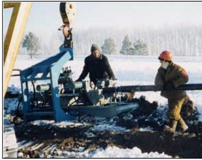
Рис. 2.15. Общий вид установки для механического соединения труб [14]
