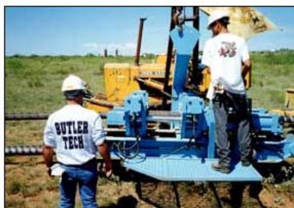
Рис. 2.16. Рабочий агрегат, подвешенный на стрелу трубоукладчика [14]
