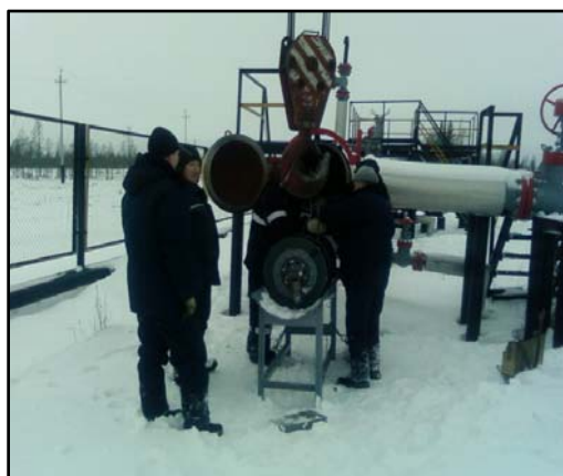
Рис. 5.15 Камера запуска очистного устройства
