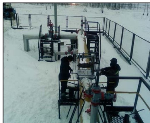
Рис. 5.15 Камера запуска очистного устройства
