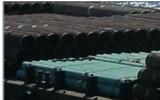
Рис. 2.6. Складирование труб на подготовленной площадке
