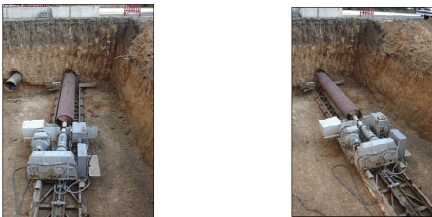
Рис. 2.24. Установка горизонтального бурения [21]
