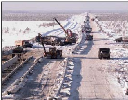
Рис. 1.9. Надземный способ прокладки промыслового трубопровода
