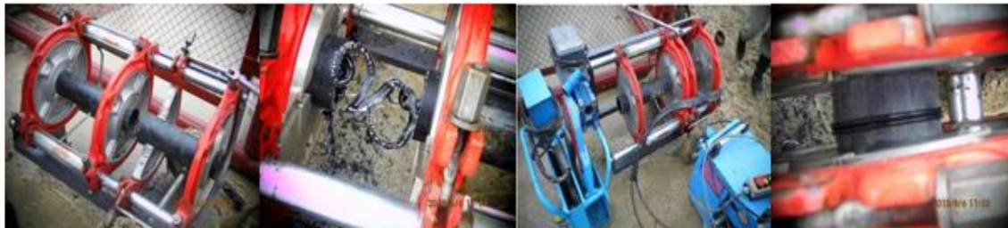
Рис.4. Сварка полиэтиленовой трубы
