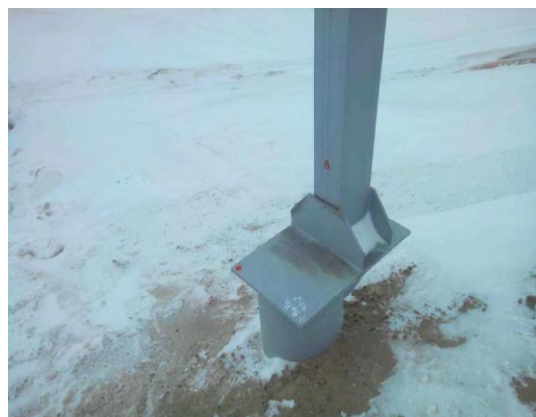
Рис. 4. Общий вид деформационной марки ДМ-2
