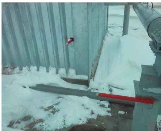
Рис. 3. Общий вид деформационной марки ДМ-1
