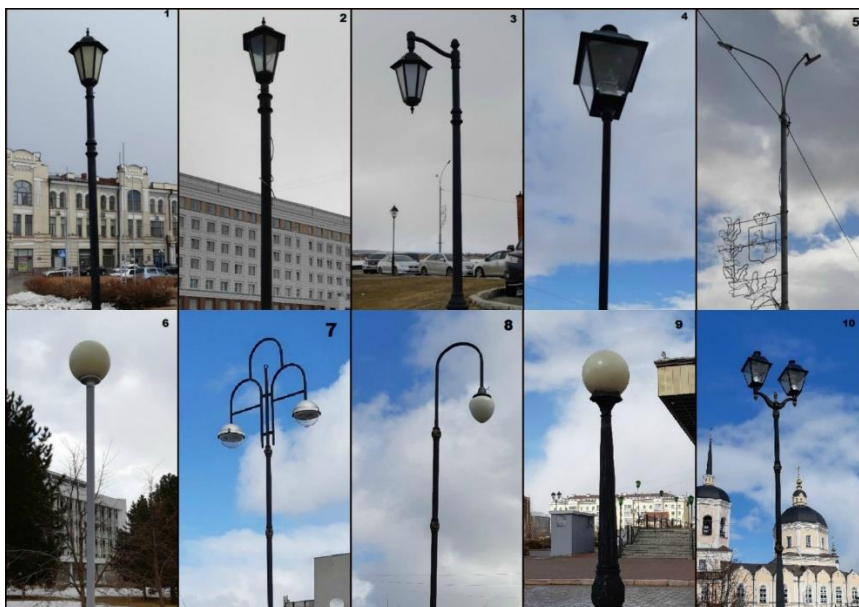
Рисунок 3 – Световые приборы, установленные на набережной г. Томска
