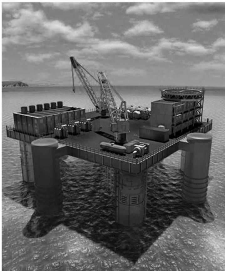
Рисунок 5. Опытная электростанция типа "закрытый ОТЕС" на базе буровой платформы
