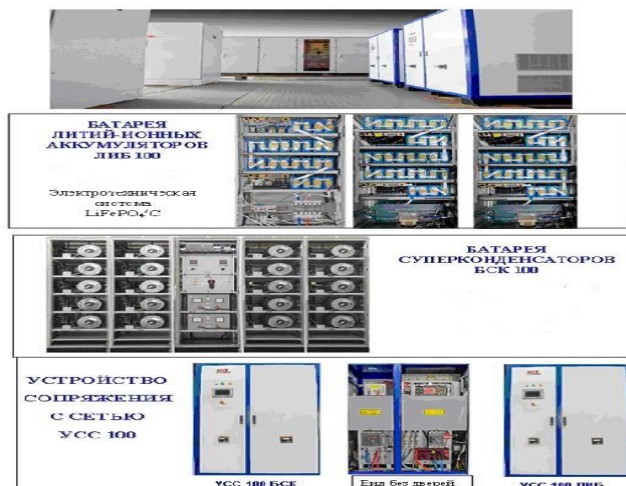
Рис.1. Общий вид ГНЭ-100 и его подсистем
