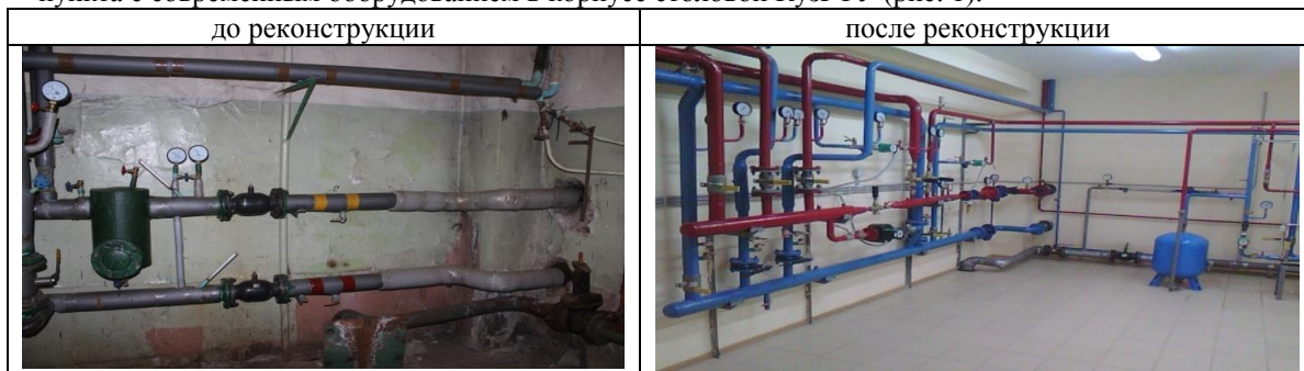
Рис.1. Тепловой пункт в корпусе столовой КузГТУ
