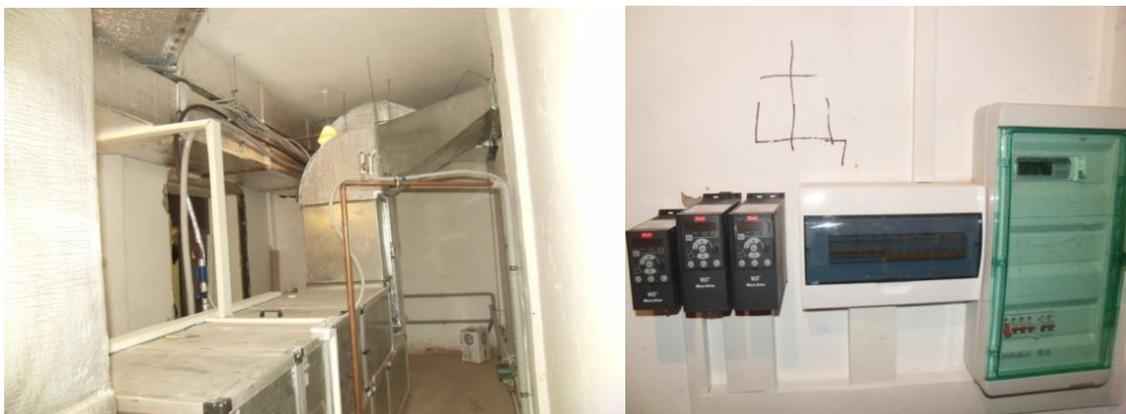
Рис. 5. Регенеративная вентиляционная установка в КузГТУ
