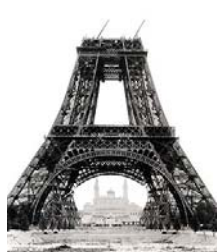
Рис. 4. Башня Эйфеля в стадии строительства
