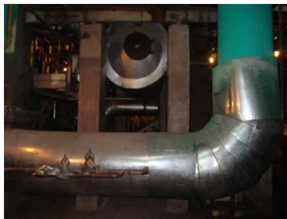
Рис. Фрагмент подогревателя, изолированного ЖКТМ «Корунд»
