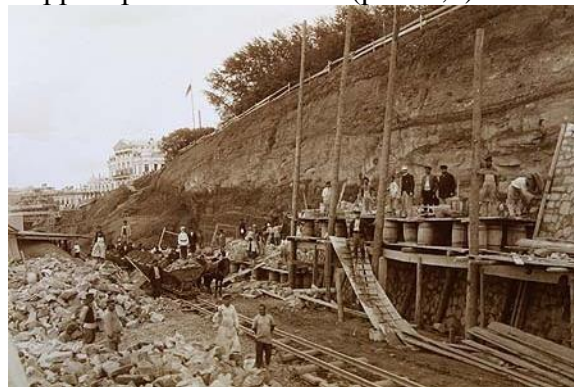
Рис. 3. Строительство подпорной стенки 1885 г.
