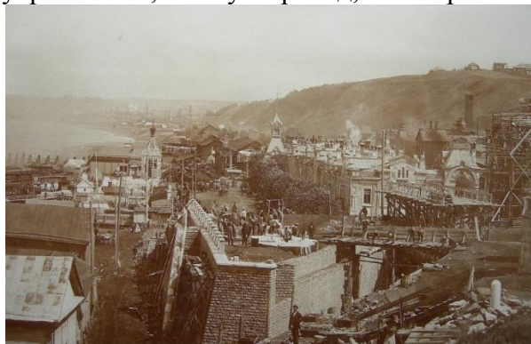
Рис. 2. Строительство путепровода 1885 г.
